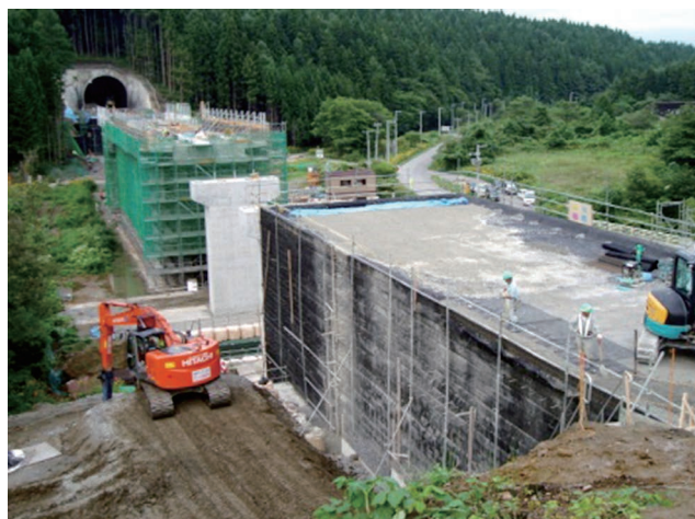
図1 補強土壁・補強土橋台の施工
