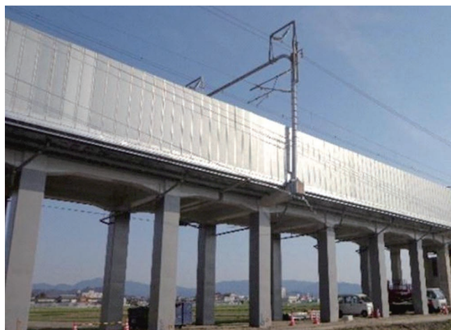
図2 RCラーメン高架橋
