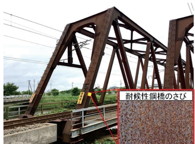
図 耐候性鋼橋
