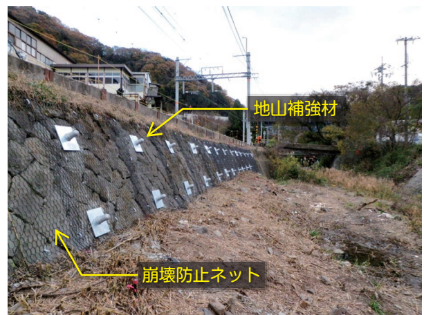
図2 補強完了後の現場状況
