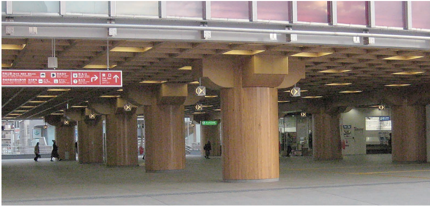
図5 駅部高架橋への適用例(奈良駅) (JR西日本提供)
