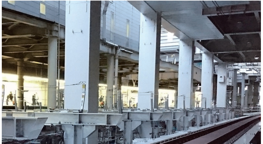
図7 角形CFT柱の適用事例(渋谷駅) (JR東日本提供)
