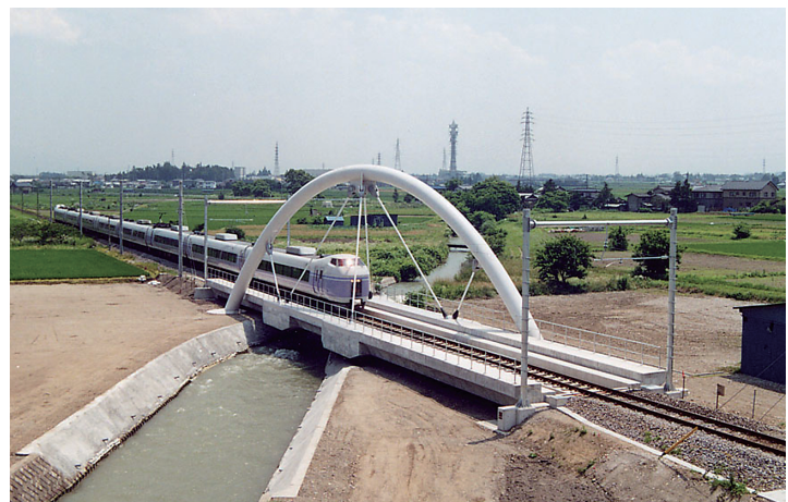
(b)アーチ橋(CFT アーチリブ・PC 桁)(JR 東日本提供)
