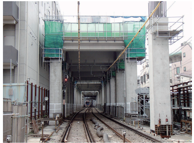
図2 営業線直上のプレキャスト高架橋の施工
