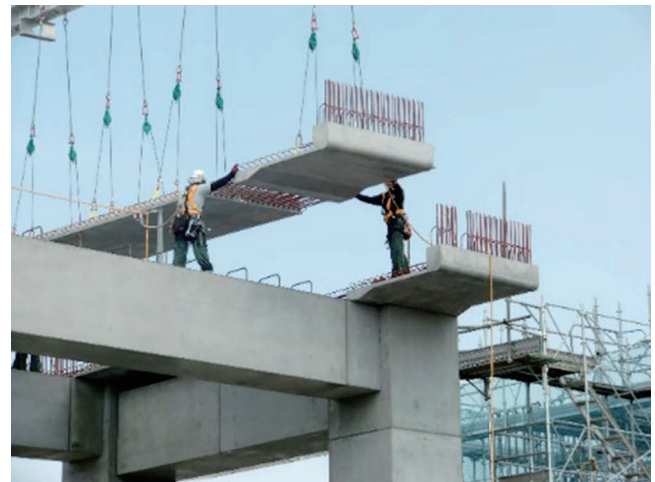
図7 一体化プレキャストスラブの架設(支保工なし)
