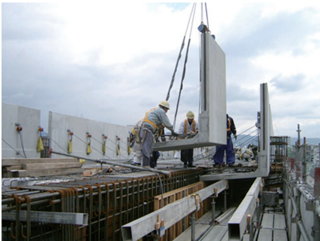
図6 片持ちスラブの架設(支保工あり)
