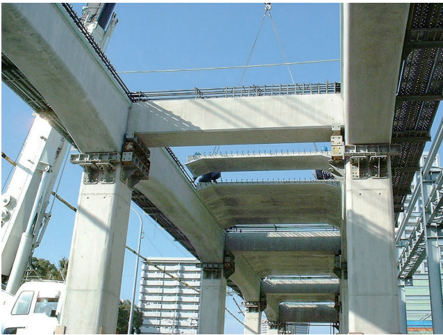
図1 プレキャストはり・スラブの施工
