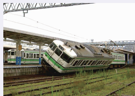
図3 2005年新潟県中越沖地震で脱線した電車
