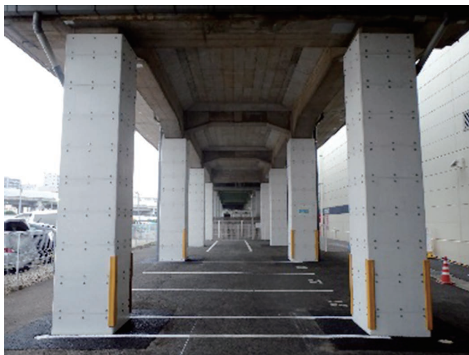
図2 耐震補強完了
