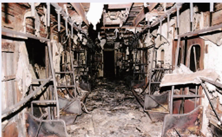
図5 韓国大邱地下鉄火災後の車内の状況 出典：「消防の動き(385号)」(消防庁) ( https://www.fdma.go.jp/publication/ugoki/items/h1504_1.pdf )
