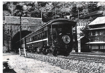
東海道本線として開業した丹那トンネル
