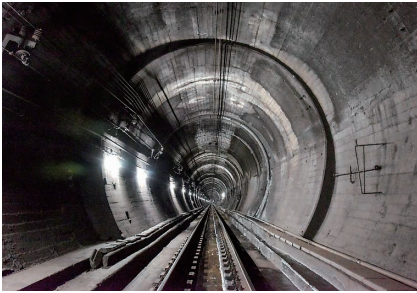
現在の関門トンネル(下り線)坑内
