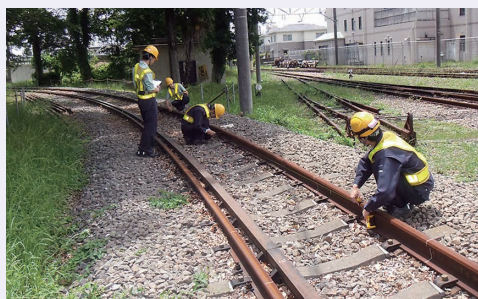
図3 水糸による軌道検測の状況 (高低・通り)
