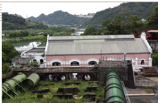
現在も稼働中の台湾電力公司桂山発電廠粗坑分廠
