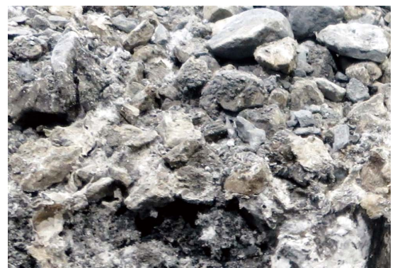
図3 補修材を混合した経年劣化バラスト
