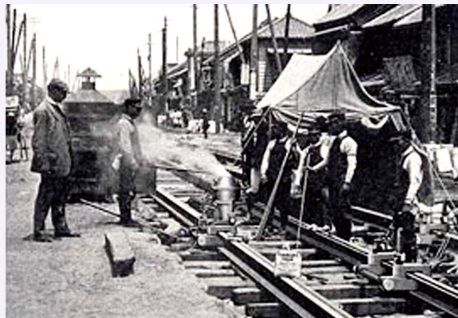
図5 1909年当時のテルミット溶接の施工状況 出典：Goldschmidt-Thermit社HP
