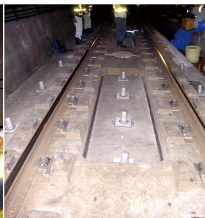
(b)打設完了後の状況
