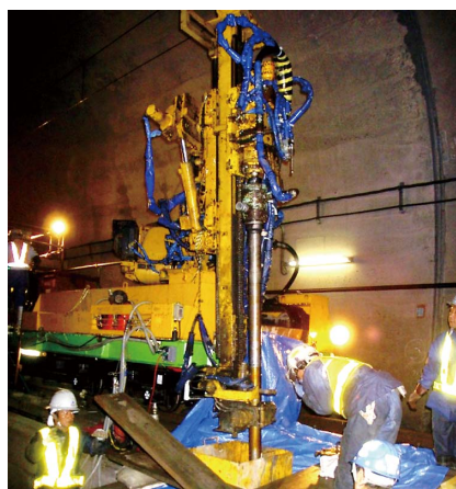
(a)打設状況
