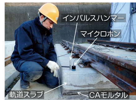
図7 打音試験の状況
