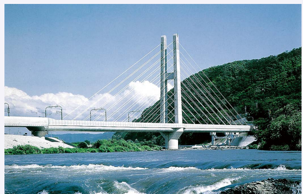
図7 第二千曲川橋りょう(基礎形式：大口径深礎) 8)
