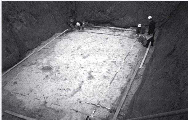
図8 高城高架橋の地盤改良部 (基礎形式：地盤改良併用の直接基礎) 9)
