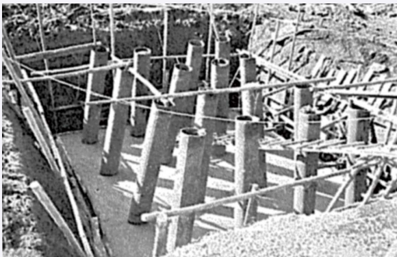
図3 柳沢高架橋の打ち込み鋼管杭の施工 4)
