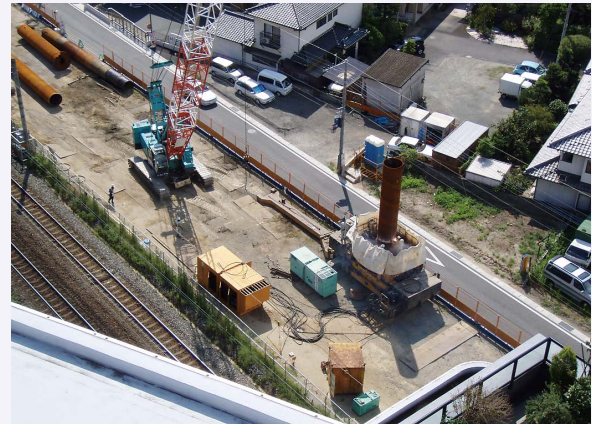
図9 熊本地区の高架橋群の回転杭の施工 10)
