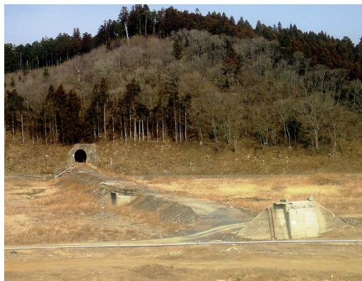
図1 東北地方太平洋沖地震の津波で被災した線路
