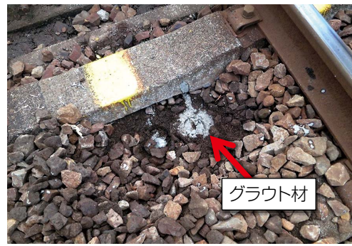
図15 グラウト材の浸透確認状況
