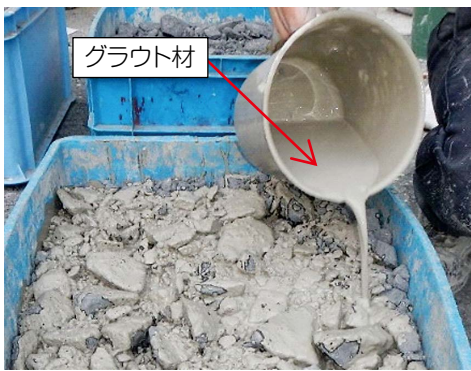
図3 グラウト材の注入状況
