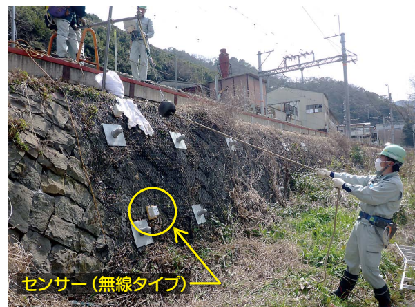
図2 石積み擁壁の振動計測
