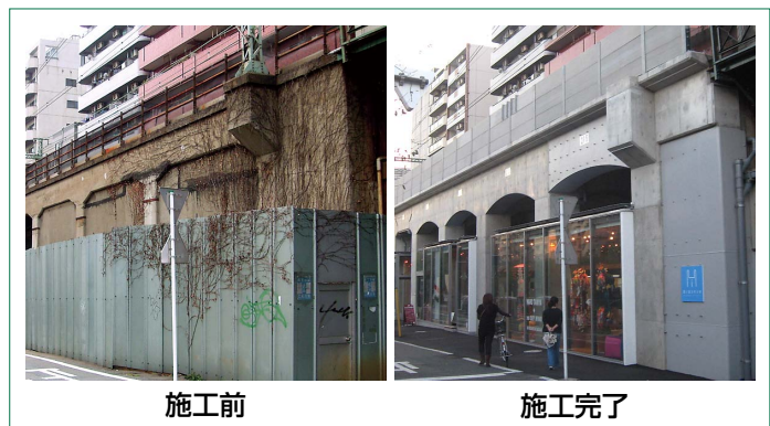
図2 工事施工前と施工完了状況
