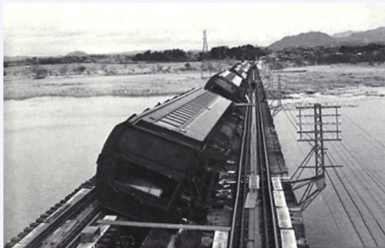
図2 室戸台風による事故事例1 2)
