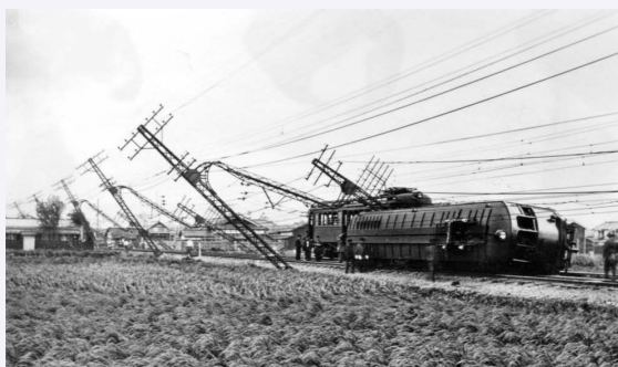
図3 室戸台風による事故事例2 3) (提供：近鉄グループホールディングス株式会社)
