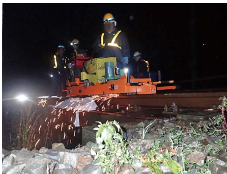
図3 専用の装置（レール削正装置）による凹凸除去の状況
