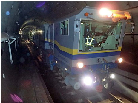
図2 専用の車両（レール削正車）による凹凸除去の状況
