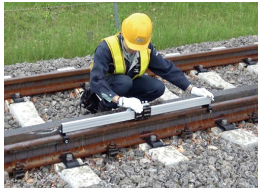
図8 レール踏面測定器によるレール凹凸の測定状況
