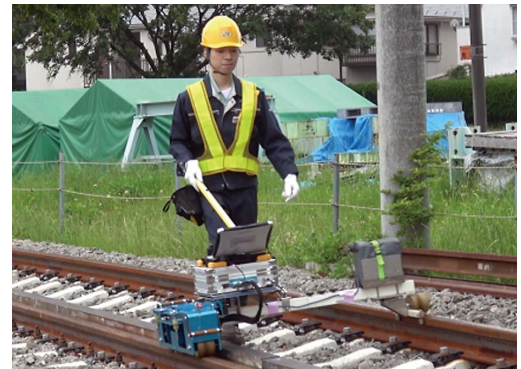
図9 レール凹凸連続測定装置によるレール凹凸の測定状況
