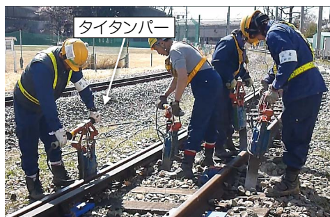
図1 つき固め補修状況
