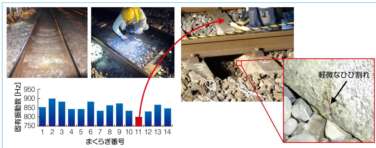
図7 実路線での打音試験とひび割れ確認
