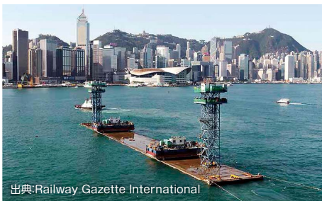
出典: Railway Gazette International 4月に完了した4本目となる鉄道海峡トンネル用の11基のケーソンの沈設
