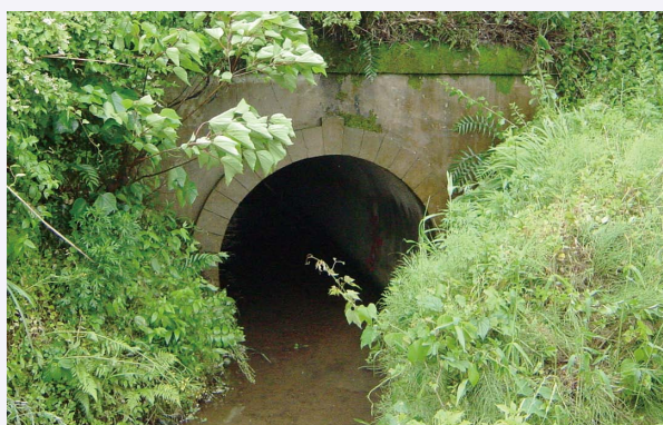
図1 日本最初の鉄道用鉄筋コンクリート構造物 (島田川 あんきよ 暗渠)
