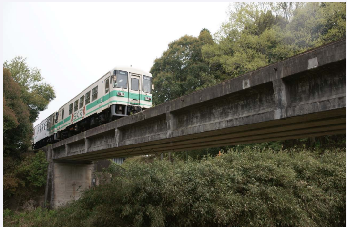
図5 日本最初の本格的な鉄道用PC橋りょう (信楽高原鐵道 第一大戸川橋りょう)
