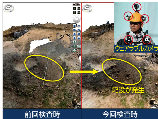
図8 VR技術を用いた盛土の検査の実験例
