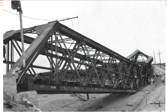
1942(昭和17)年8月に水戸陸軍爆撃場で行われたトラス橋の耐爆試験
