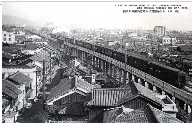
鉄筋コンクリートラーメン高架橋を用いた神戸市街高架線（第一期）
