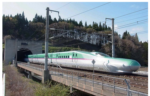
図2 本電柱耐震補強の施工例(青函トンネル坑口付近)
