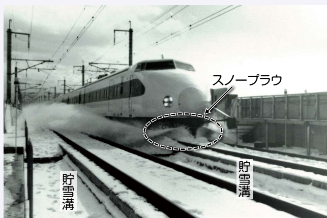
図4 排雪状況 (開業前の排雪試験)
