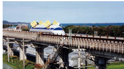
図4 MLU002Nによる走行実験(空力ブレーキ試験)
