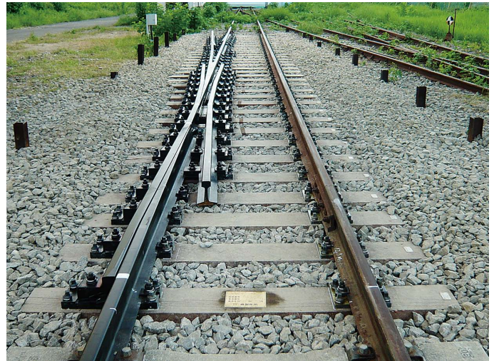
図9 レール鋼製ノーズ可動クロッシングの敷設状況
