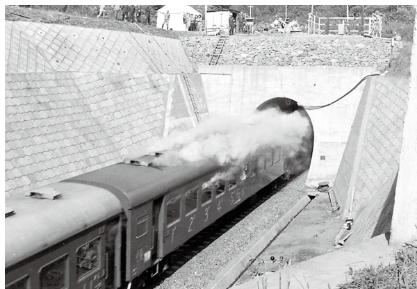
図1 宮古線猿峠トンネルでの列車火災試験(1974年10月)
