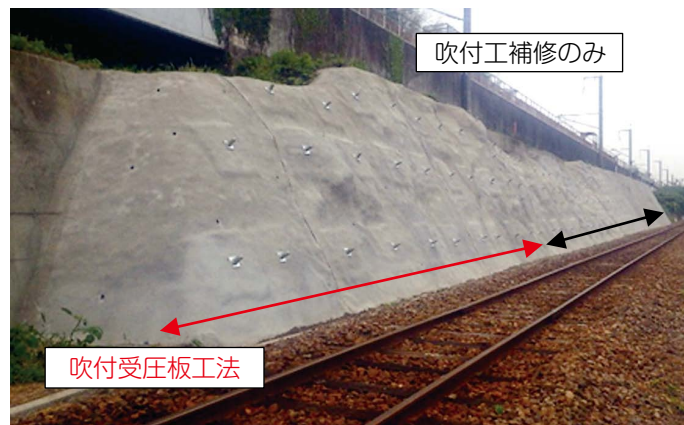
図10 鉄道における吹付受圧板工法の施工例
