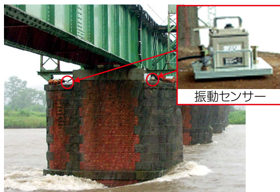
図4 増水時の橋脚の健全性評価手法
