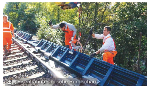
ウィンチ(巻上機)を用いたゴム製素材のミニ防音壁の取り付け
