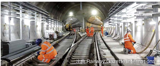
出典: Railway Gazette International 軌道敷設が終了したステップニー・グリーンに分岐点
