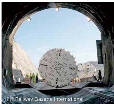
大西洋回廊のトンネルに投入されたトンネルボーリングマシン
