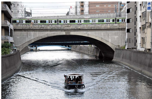
日本初のカタナリー曲線を用いた鉄筋コンクリート橋梁として大河戸の設計で完成した神田川橋梁
