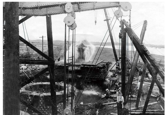
大河戸の考案で荒川橋梁の基礎工事に用いられた注水式(奥)と機械式(手前)井筒沈下工法
