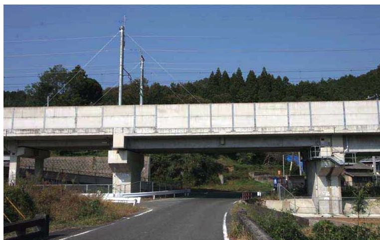
図1 電車線柱への支線の取り付け状況
