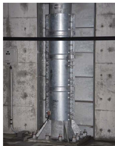
図2 振動抑制部材の外観
