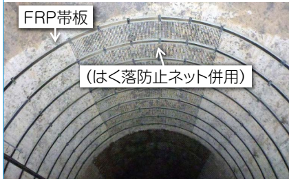
図3 バサルト帯板接着工法 2)
