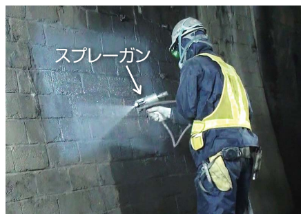
図5 樹脂吹き付けの様子
