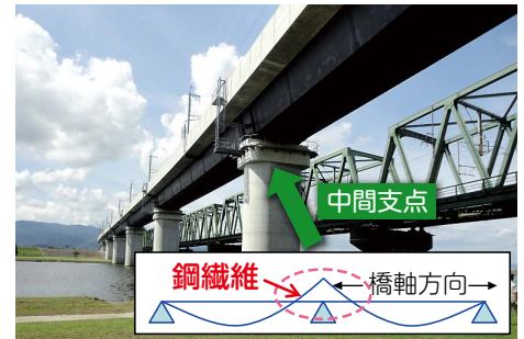
図8 合成連続桁の負曲げ区間
