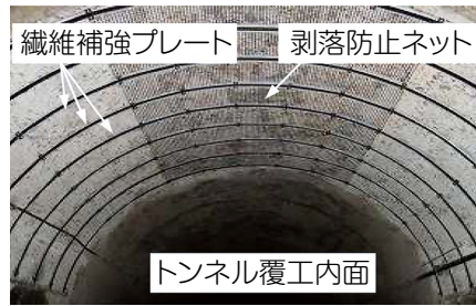
図10 鉄道トンネルのバサルト繊維の適用例(プレート) 2)
