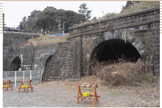
廃線跡に現存する東海道本線の初代・牧の原トンネルの金谷方坑門（右）
