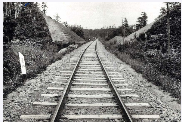
図5 手塩線温内隧道東口 7) まくら木周辺のバラストには細粒分が多い。
