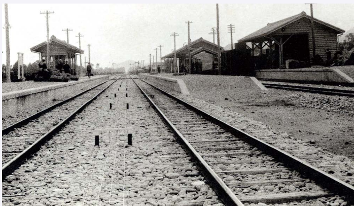
図4 日豊南線富高停車場(現、日豊本線日向市駅) 6) バラストの粒径が現在よりもやや大きい。
