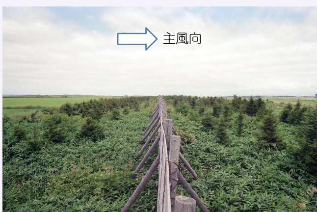
図3 丸松2号林地(旧羽幌線丸松・更岸間)に設置された吹雪防止柵(夏)
