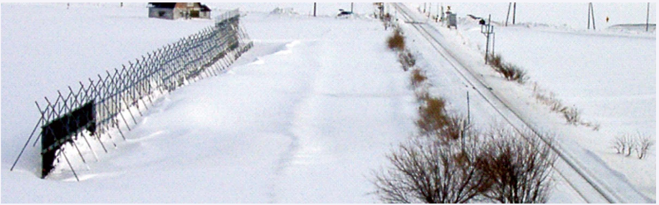
図7 異なる仕様の遮風材を用いた仮設防雪柵の効果確認試験状況(学園都市線 あいの里公園・石狩太美間)
