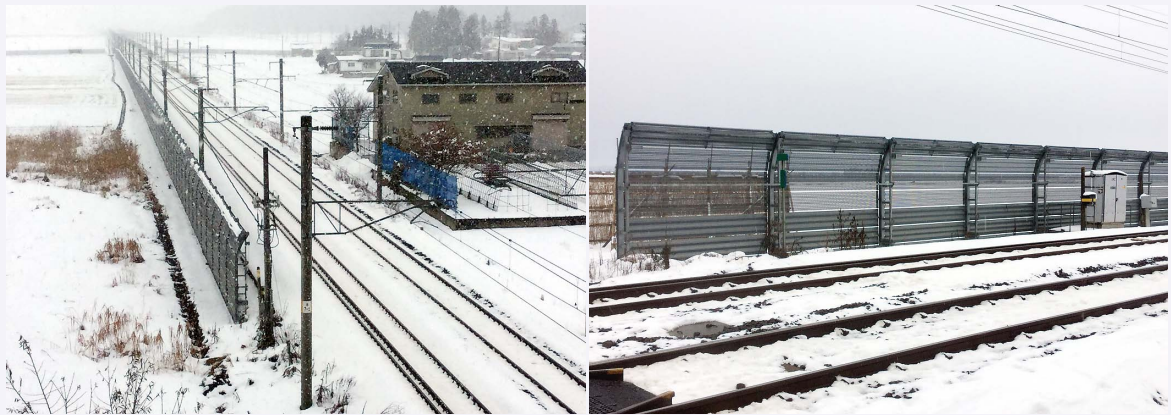
図8 奥羽本線(神宮寺・峰吉川間)に設置された防雪柵
