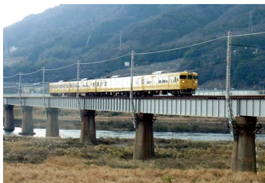
図3 大田川橋りょう (奥：横川方、手前：可部方)
