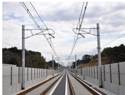
図7 き電ちよう架式コンパウンドカタナリー
