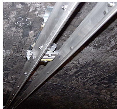
図8 狭小トンネル用剛体電車線
