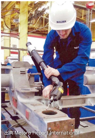
台車枠特修工事の様子
