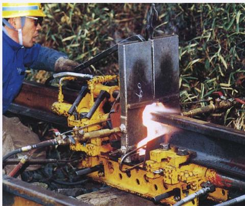
図9 小型圧接機による線路脇での施工
