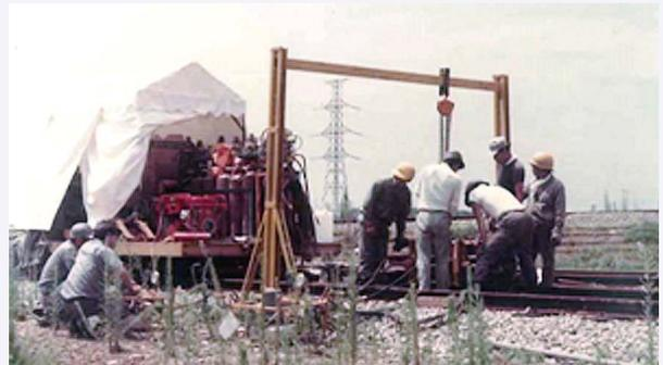
図6 PGP型ガス圧接機による山陽新幹線での実施工
