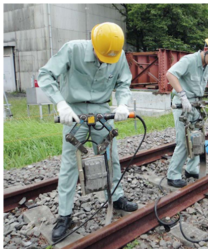
図1 バラストのつき固め作業
