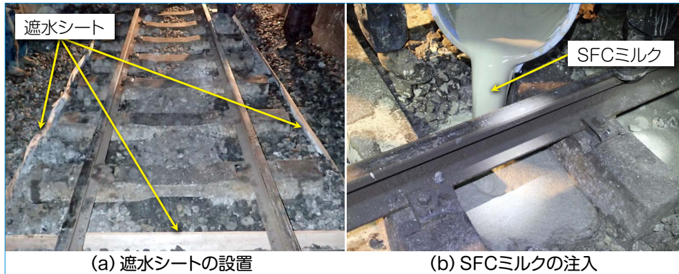
図11 営業線における試験施工の様子
